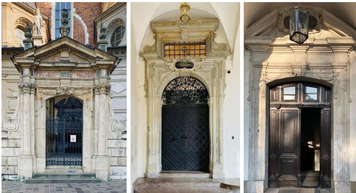
Il. 19. Od lewej strony: południowa brama muru otaczającego katedrę na Wawelu, portal klatki Senatorskiej na Wawelu, portal wiodący na krużganki kościoła franciszkanów w Krakowie
