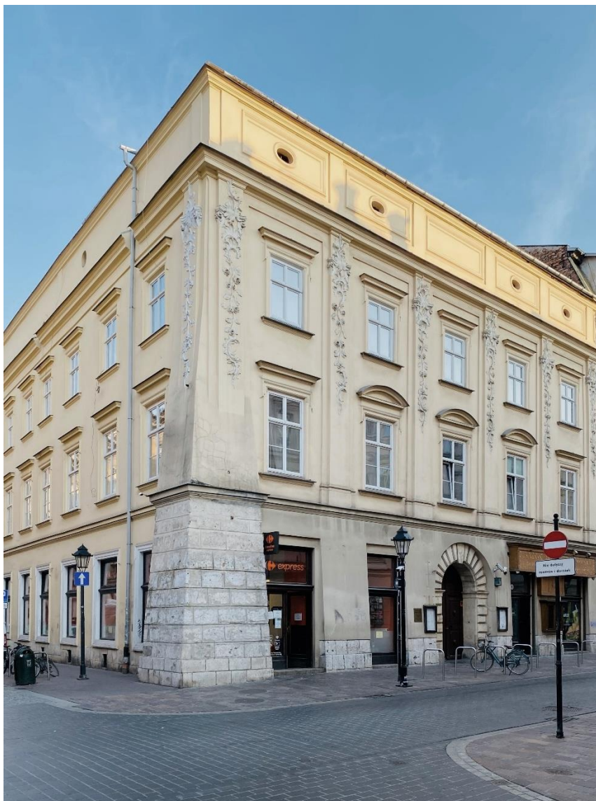
Il. 45. Kamienica przy ul. Sławkowskiej 10 w Krakowie
