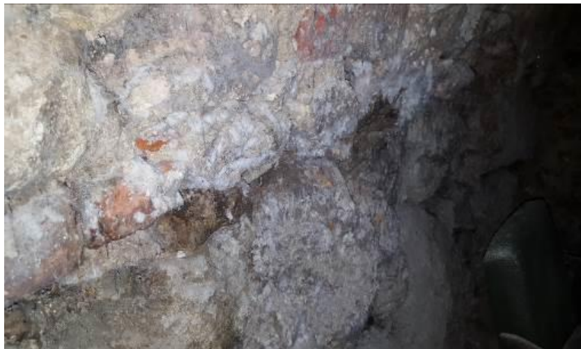
Rys. nr 9. Miejscowe wysolenia muru. [1.3]
