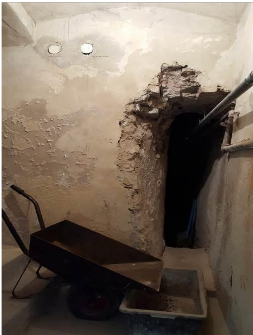
Rys. nr 25. Przebarwienia tynków, wysolenia, ubytki muru przy przejściu podziemnym – brak odpowiedniego wykończenia i zabezpieczenia - drzwi. [1.3]
