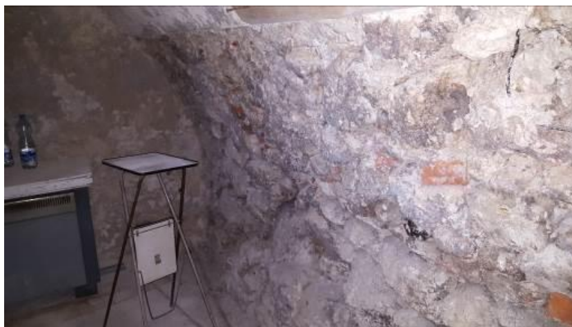
Rys. nr 13. Wysolenia muru, brak tynku, ubytki zaprawy w murze. [1.3]
