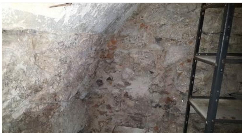
Rys. nr 11. Miejscowe wysolenia muru, przebarwienia i odrywanie się tynku na sklepieniu łukowym. [1.3]
