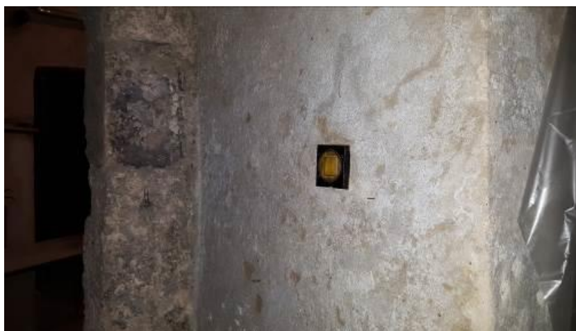
Rys. nr 14. Przebarwienia tynków, miejscami jego brak, instalacja elektryczna starego typu. [1.3]
