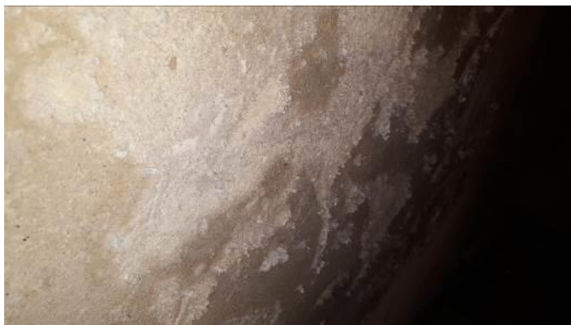
Rys. nr 20. Przebarwienia tynków, ubytki muru przy przejściu podziemnym. [1.3]
