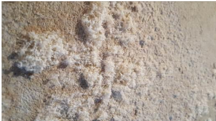
Rys. nr 23. Wysolenia na powierzchni ścian komunikacji. [1.3]
