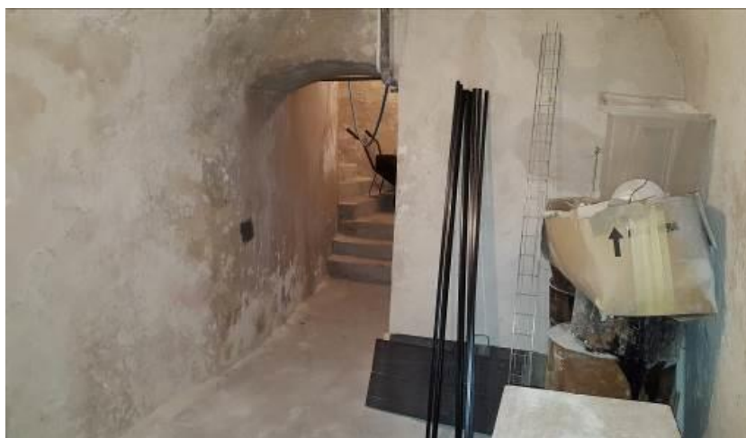
Rys. nr 16. Wysolenia sufitu i ściany - komunikacja. [1.3]
