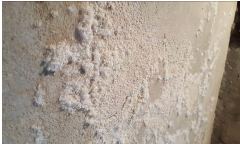
Rys. nr 21, 22. Wysolenia na powierzchni ścian komunikacji. [1.3]
