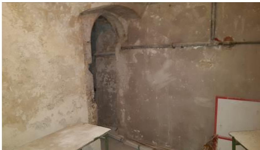
Rys. nr 17,18,19. Przebarwienia tynków, miejscami wysolenia, brak uporządkowania komunikacji, brak odpowiedniego wykończenia wierzchniego schodów - komunikacja. [1.3]
