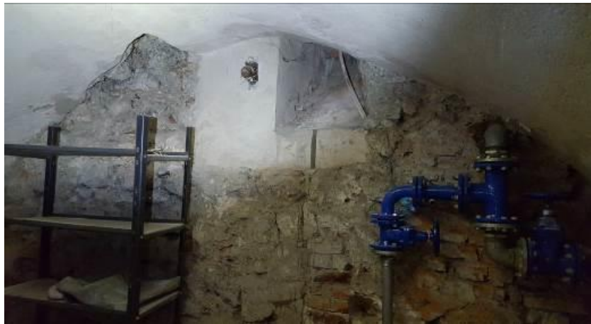
Rys. nr 7. Brak tynków ścian, miejscami wypłukanie zaprawy muru. [1.3]
