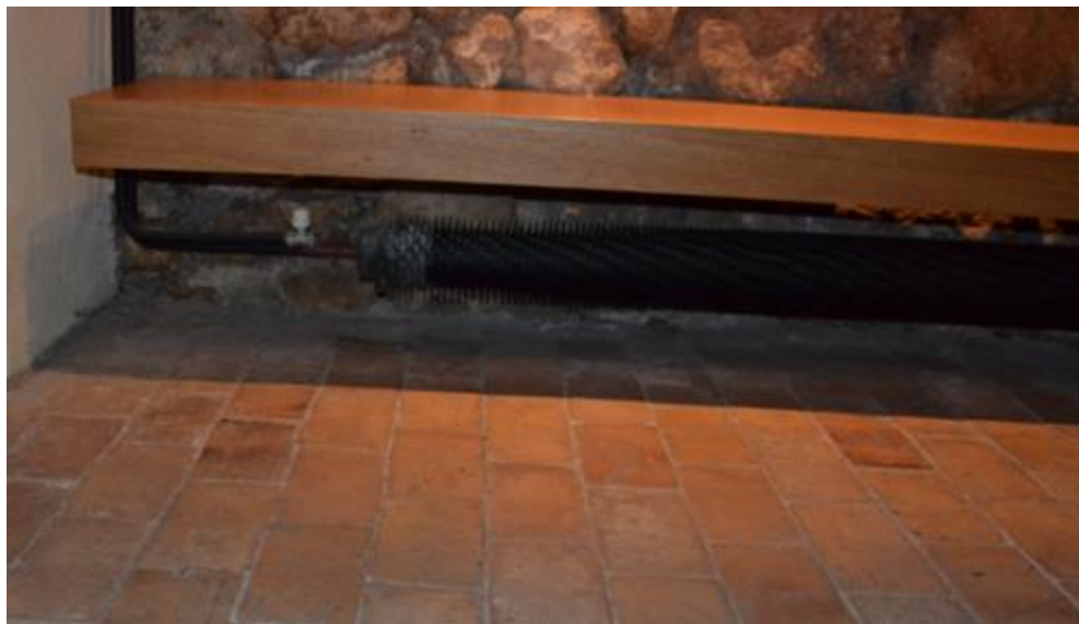
Rys. 1. Istniejący grzejnik pod ławką w kaplicy [źródło: własne].
