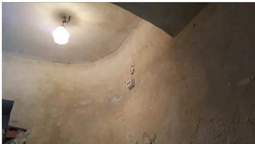
Rys. nr 24. Przebarwienia tynków ścian i sufitu, brak wyrównania powierzchni ścian. [1.3]
