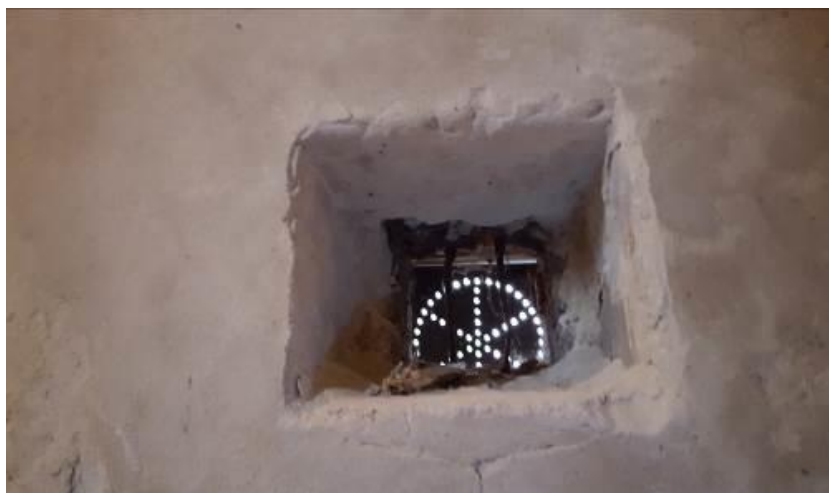
Rys. nr 15. Brak oszklenia, ramy okiennej w otworze, skorodowane okratowanie. [1.3]
