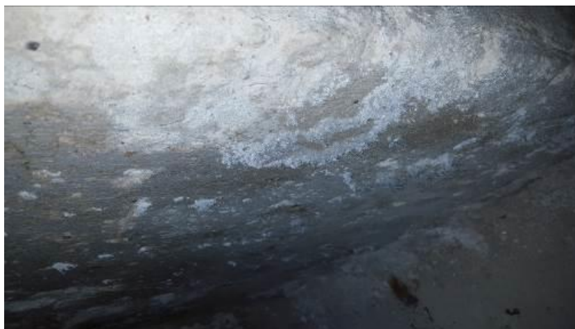
Rys. nr 16. Wysolenia sufitu i ściany - komunikacja. [1.3]
