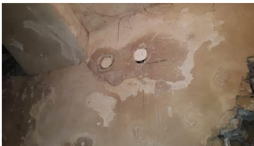
Rys. nr 20. Przebarwienia tynków, ubytki muru przy przejściu podziemnym. [1.3]
