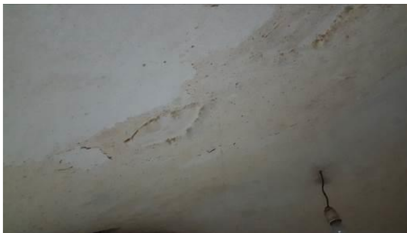
Rys. nr 10. Zawilgocenia sufitu, ubytki tynku z farbą, łuszczenie się farby. [1.3]
